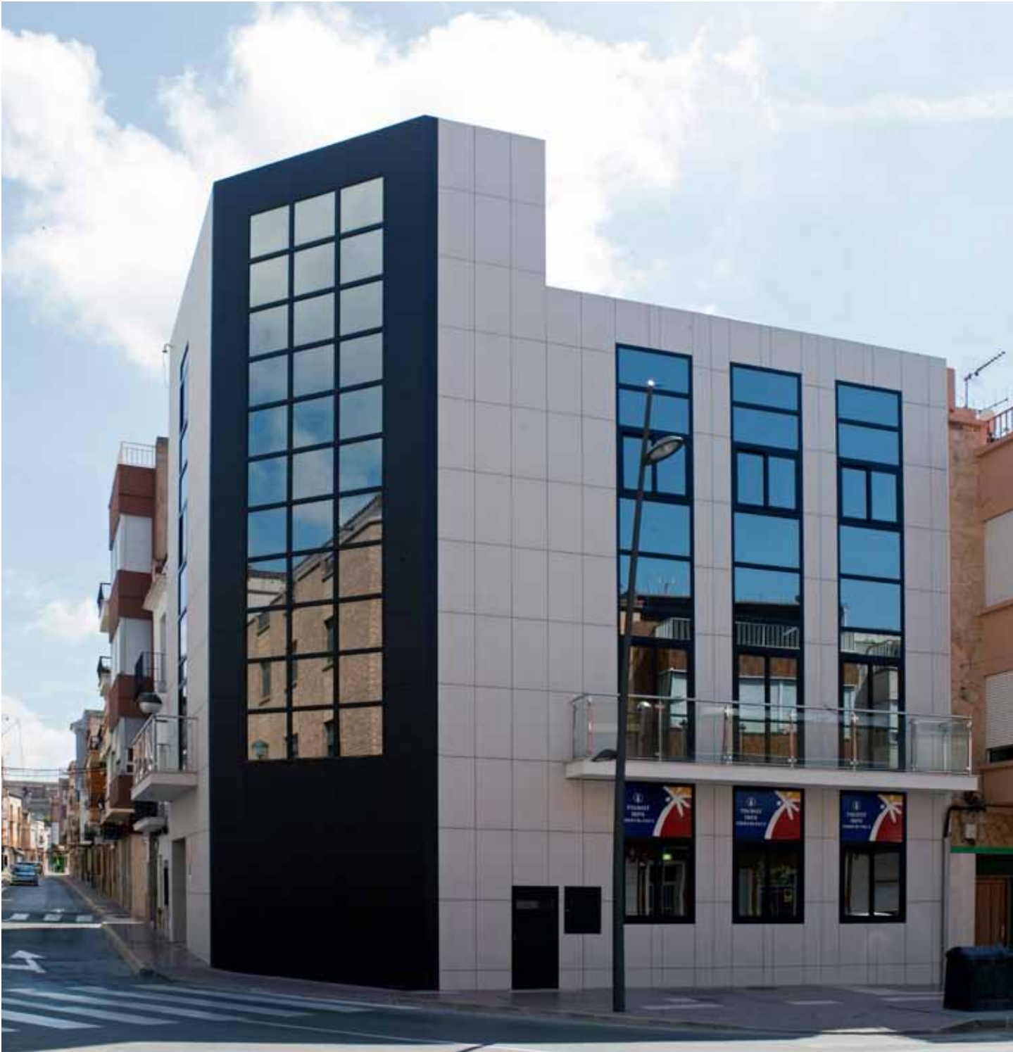
TOURISM CENTRE. CASTELLÓN, SPAIN. Arquitecto: José Luis Rokiski.
