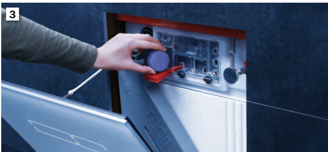
3 Ubacivanje: tablete za čišćenje padaju u prihvatnu košaricu gdje se otapaju u vodi u spremniku te svojim svojstvima omogućavaju vrhunsku higijenu.
