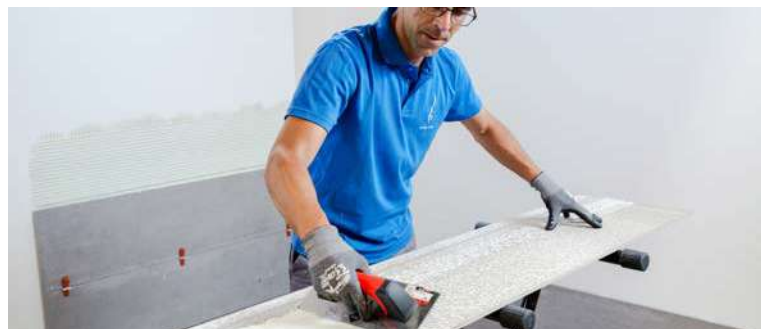
Spread the adhesive cement with a toothed trowel on the tile | Extiende el cemento de agarre con una llanta dentada sobre la pieza | Étendre le ciment à prise rapide à l'aide d'une spatule dentée sur la pièce | Verstreichen Sie den Klebemörtel mit einem Zahnspachtel auf der Fliese
