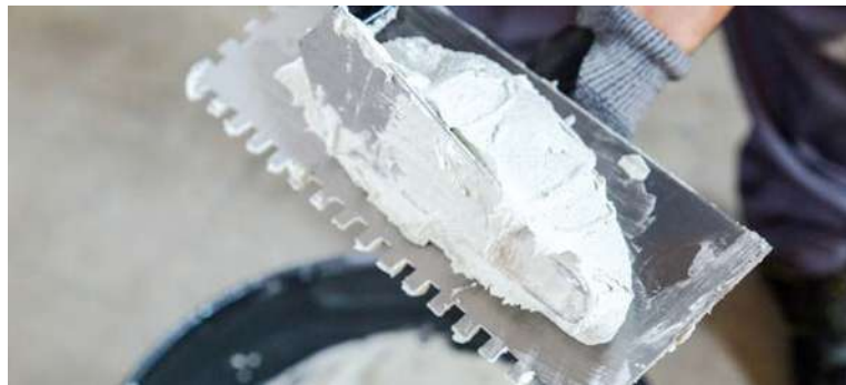
Spread the adhesive cement with a toothed trowel | Extiende el cemento de agarre con una llanta dentada | Étendre le ciment à prise rapide à l'aide d'une spatule dentée | Verstreichen Sie den Klebemörtel mit einem Zahnspachtel
